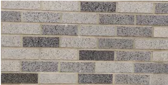
Maçonnerie de briques existantes et nouvelles
